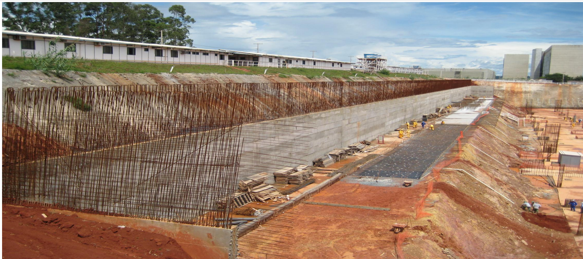
Foto 8 – Aço Vertical da cortina do eixo 1 - trechos I,II e III ref. Item 03.01.600 do Memorial descritivo
