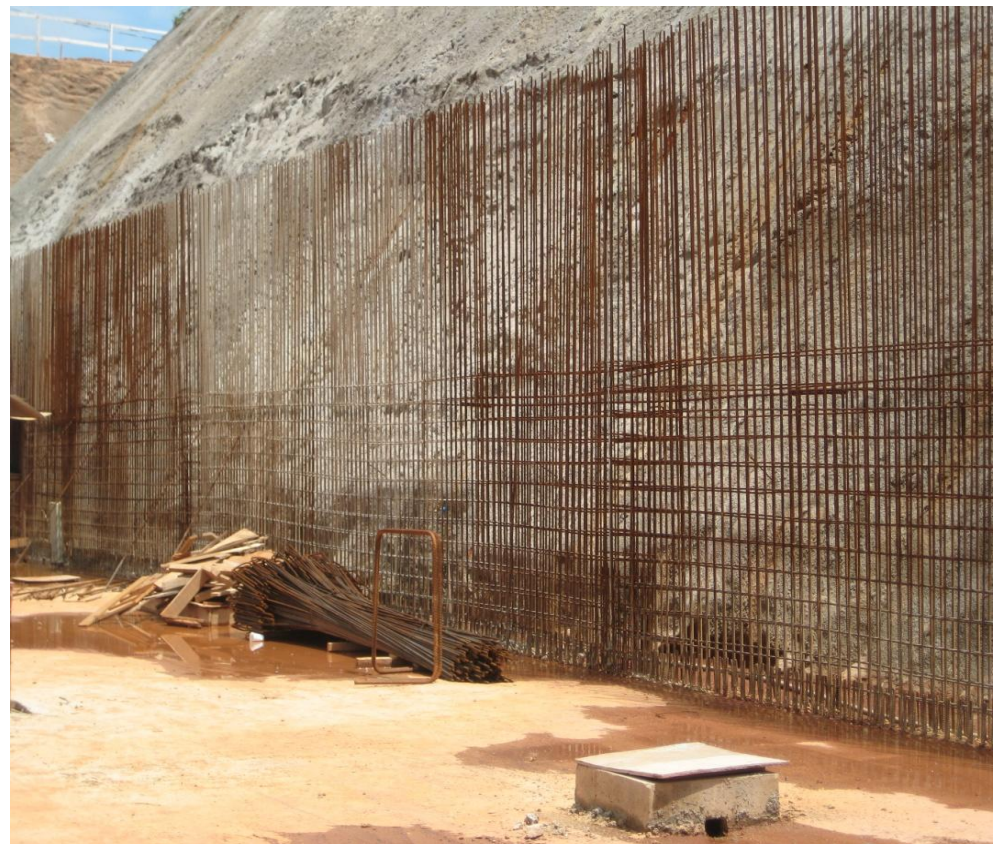
Foto 7-Aço horizontal (11 costelas) da parede 10 (eixo X) do eixo 3 ao 8 até nível 1044,72- trecho III , ref. Item 03.01.600 do Memoria descritivo
