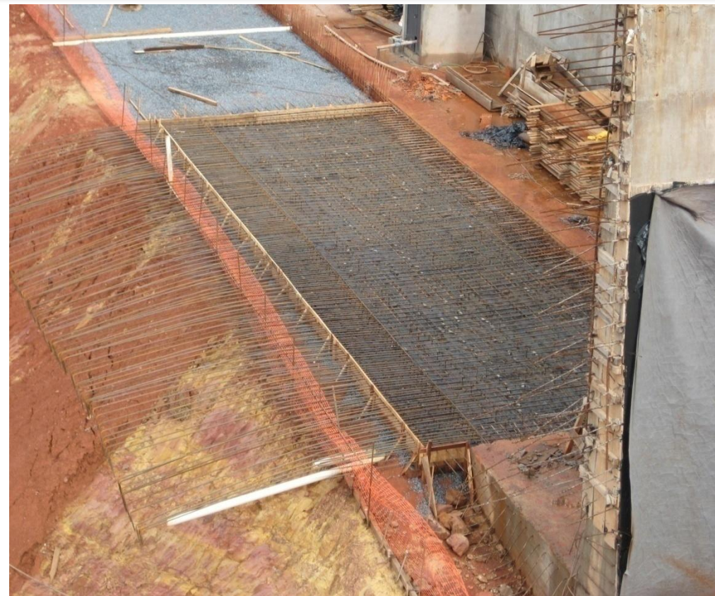
Foto 10 – Aço Laje piso subsolo nível 1049,55 faixa entre eixos 1-2 com largura de 5,67m- trecho III, ref. Item 03.02.500 do Memorial descritivo
