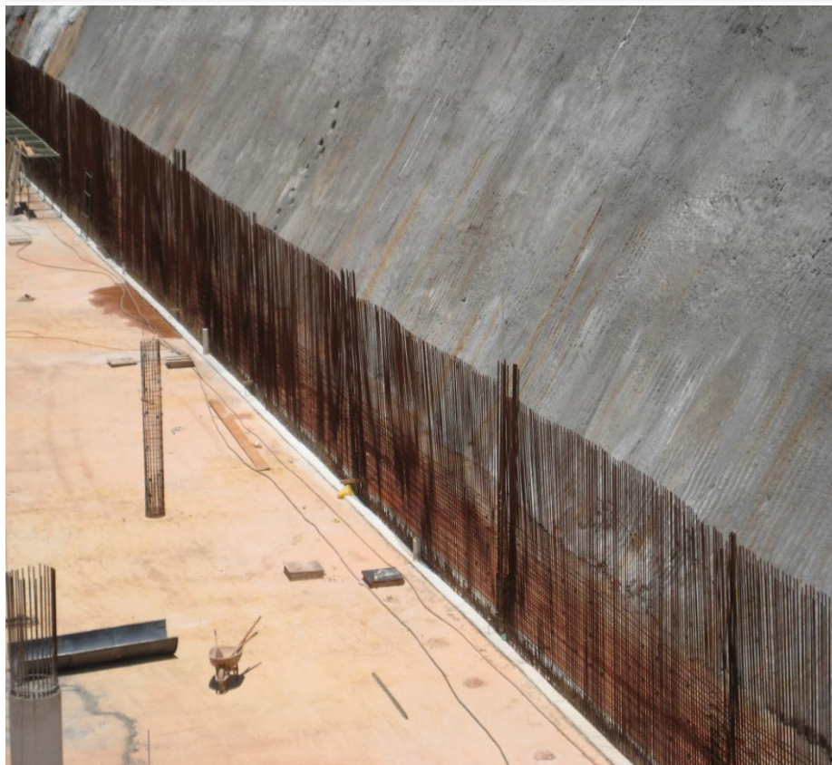
Foto 9 – Aço Horizontal (13 costelas) da parede do eixo 14 até nível 1045, do eixo B ao V - trechos IV, V e VI ref. Item 03.01.600 do Memorial descritivo
